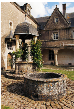
Le puits et son bassin
