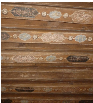
Plafond de l'office
